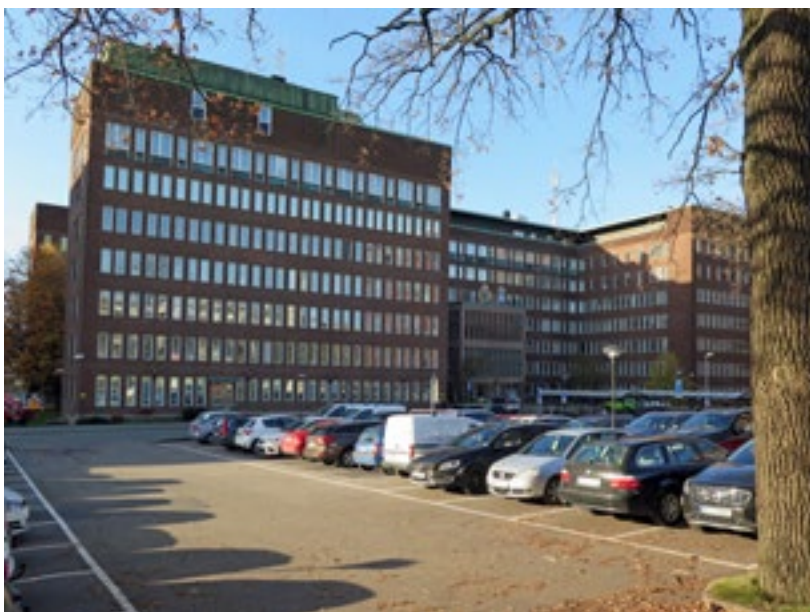
Hörnet mot Smålandsgatan. Närmast polishuset markparkering. Byggnaden har inga entréer mot Smålandsgatan.
